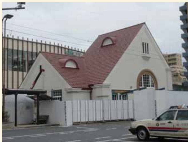
旧国立駅舎再築工事 写真提供 井桁スレート（株）
